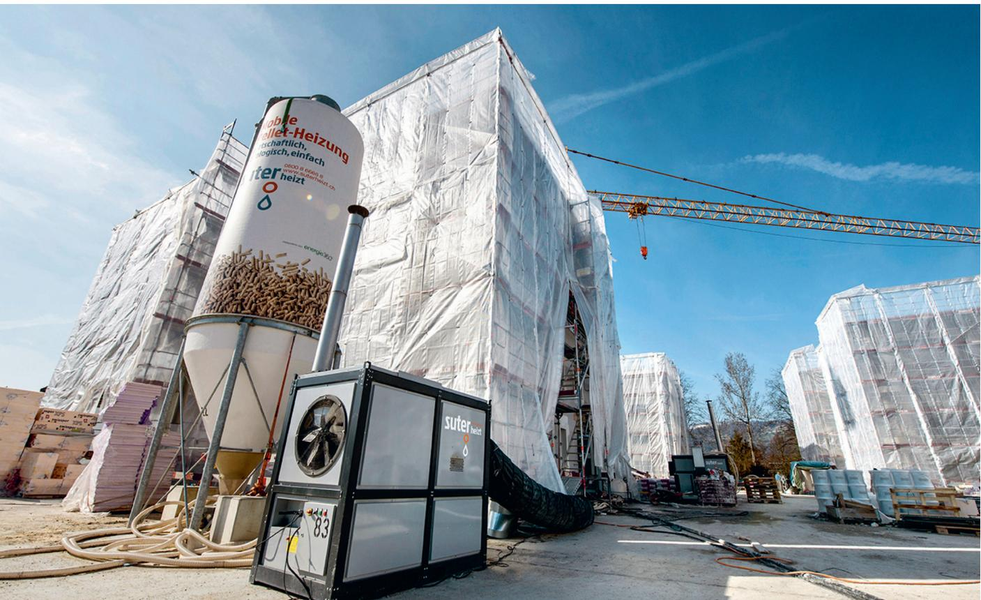
Mobile Warmluft-Heizung mit Holzpellets im Einsatz für die Beheizung des Fassadenbereichs. Über den gleichen Pelletsilo lassen sich zusätzliche Heisswassermodule für den Innenbereich koppeln.
