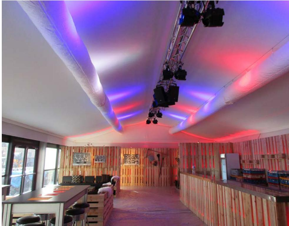
Die erzeugte Wärme wird mit Warmluftschläuchen gleichmässig verteilt und sorgt für eine wohlige Wärme in den temporären Bauten.
