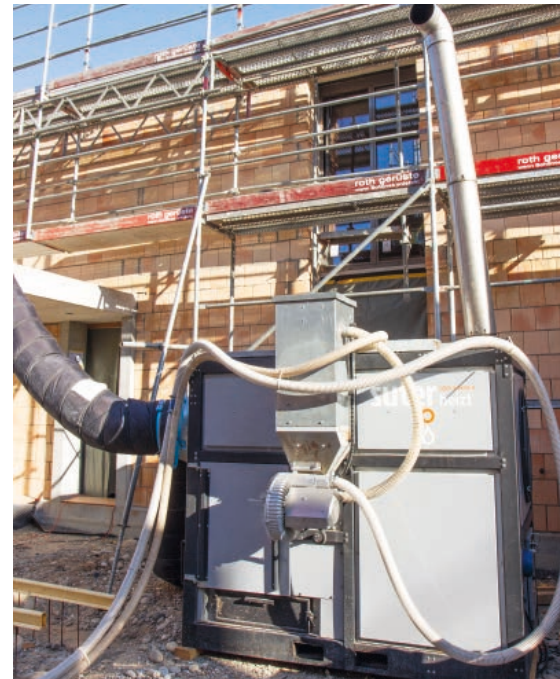
Durch den Einsatz pelletbefeuerter Heizanlagen von Suter Entfeuchtungstechnik konnten die Rohbauten der Siedlung «Weitblick» getrocknet und so Bauverzögerungen aufgrund der nassen Witterung verhindert werden.
