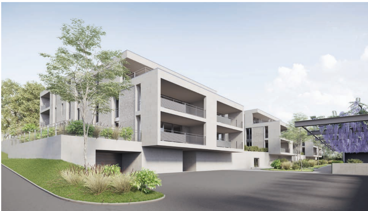
Die Architektur der Siedlung «Weitblick» in Rombach wird geprägt durch die Massivbauweise mit einem doppelschaligen Aussenmauerwerk.
