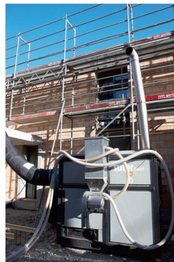
Durch den Einsatz pelletbefeuerter Heizanlagen von Suter Entfeuchtungstechnik lassen sich Rohbauten effizient trocknen und so Schimmelprobleme und Bauverzögerungen verhindern.
